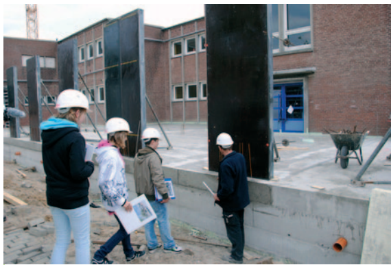
Baustellenbesichtigung mit dem Polier (Foto: SchulBaustelle Klima)
